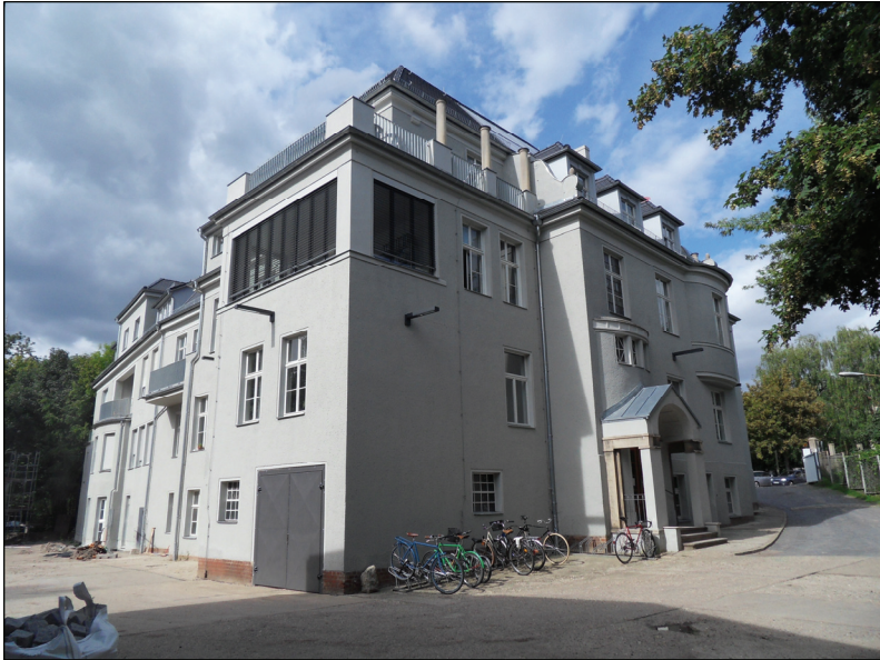
Übersicht 15: Designhaus Halle (Saale)
