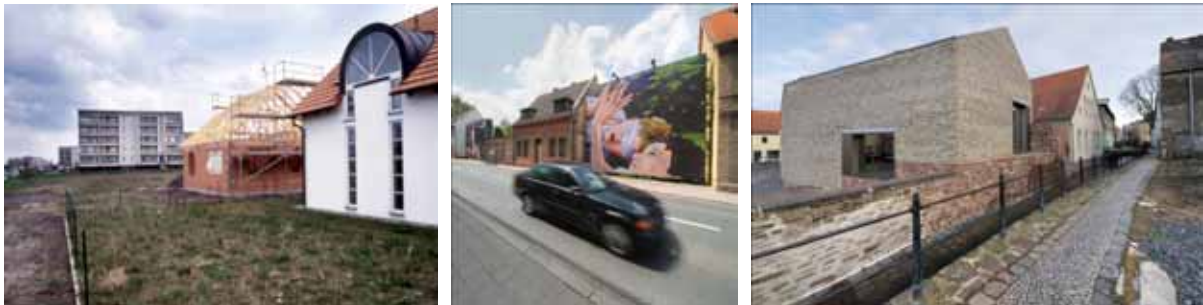
Foto links: Stadtrandbebauung vor und nach 1990 in Sachsen-Anhalt.
