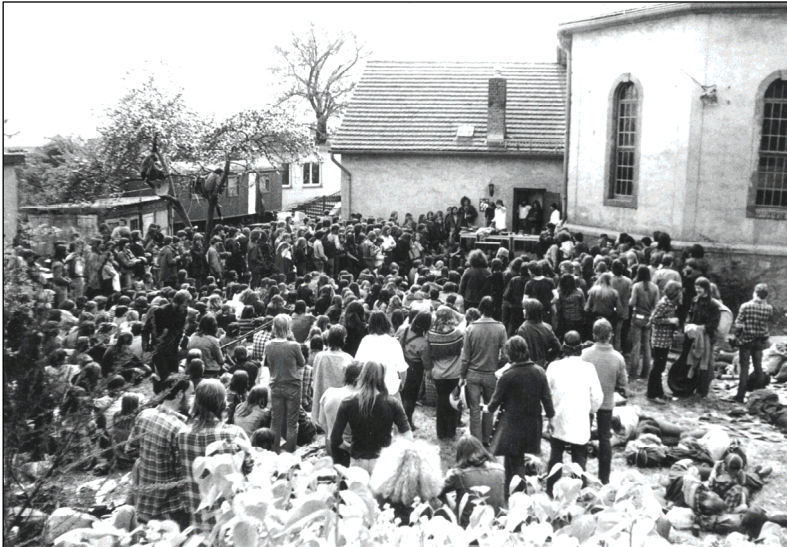
Übersicht 62: Werkstattage in der Halle-Neustädter Kirche, Frühjahr 1979
