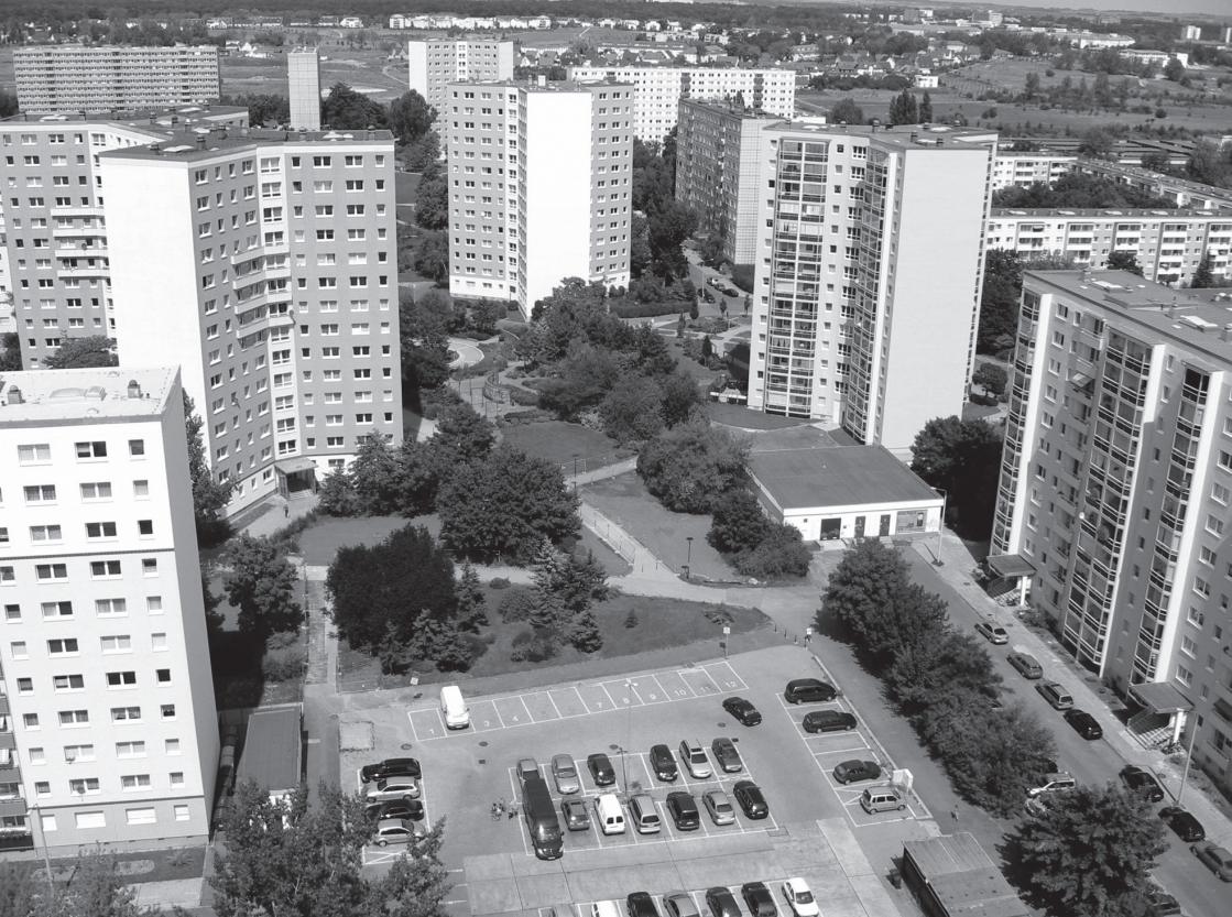
Upsilon-Hochhäuser im vormaligen IV. WK, saniert
