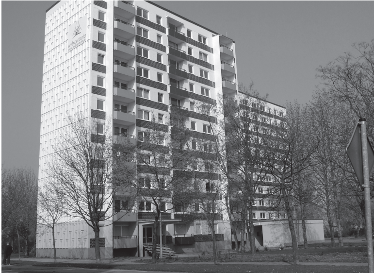
Saniertes Elfgeschosses an der Saaleau
