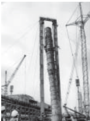
1973/74: Inbetriebnahme der N-Linie mit 2 Ammoniak-, 3 Harnstoffanlagen sowie einer neuen Salpetersäureanlage, die auch Säure herstellt.
