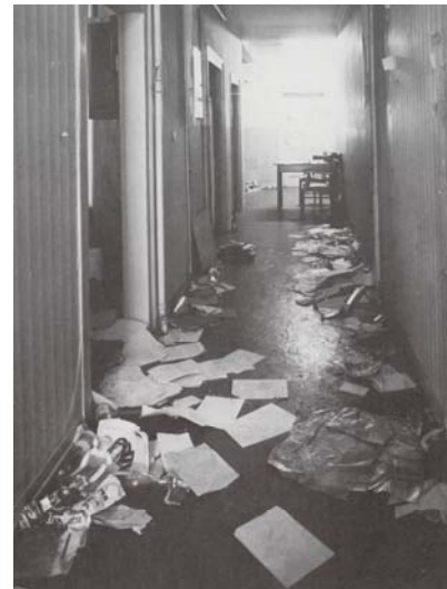
Die Luftschutzhilfsdienststelle in Tübingen nach der Besetzung. 22
