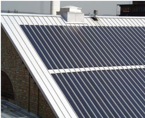
Abb. 6 Optische Wirkung der Fotovoltaik-Anlage
