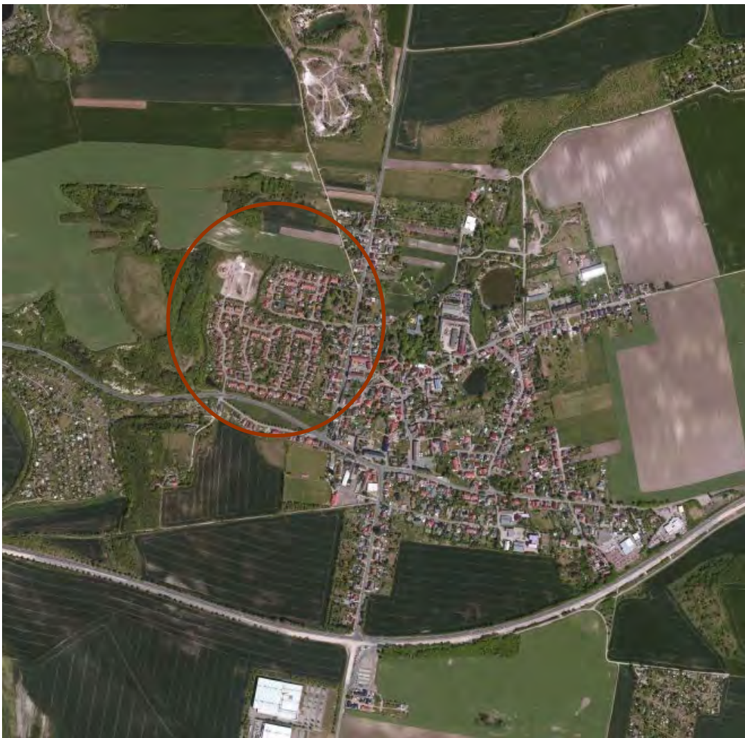
Abb. 54: Bennstedt, Wohngebiet „Brandwende“
