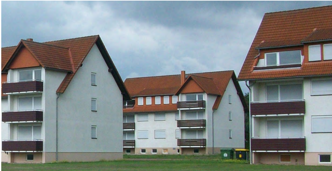
Abb. 26: Mehrfamilienhäuser in Nedlitz (nordöstlich von Dessau an der Grenze zu Brandenburg). Hier wurde am Bedarf vorbei gebaut
